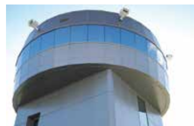
Panomera-Kameras am Tower zur Überwachung des Flugfeldes (Bild: Dallmeier/Flughafen Neapel)
