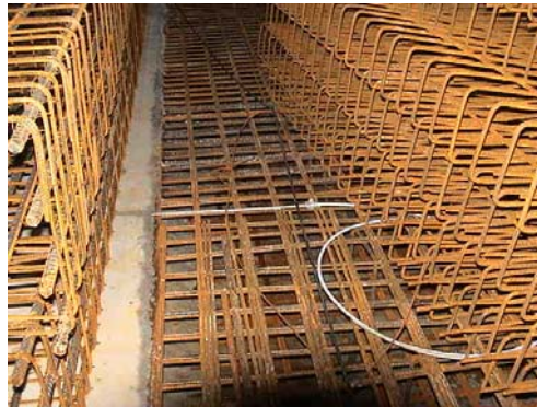
Abbildung: eingebaute Ableitungen in der Armierung mit gleichem Material
