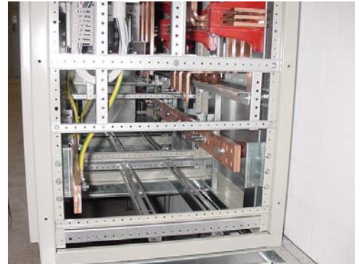
Abbildung: 5-Leiter-Schienen-System mit „abgesetzter“ Erdungsschiene
