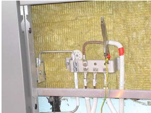
Abbildung: prüffähiger Anschluss zusätzlicher Erdungsseile
