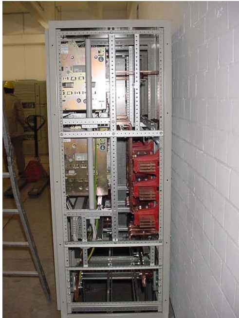
Abbildung: 5-Leiter-Schienen-System mit „abgesetzter“ Erdungsschiene
