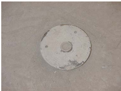
Abbildung: Erdungsfestauslasspunkt Fundamenterder
