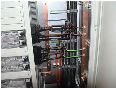
Abbildung: 5-Leiter-Schienen-System mit „abgesetzter“ Erdungsschiene
