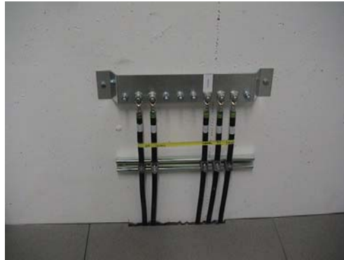
Abbildung: Fundamenterder und Potentialausgleich
