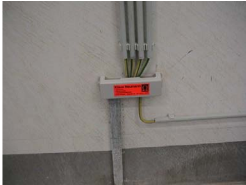
Abbildung: Fundamenterder und Potentialausgleich
