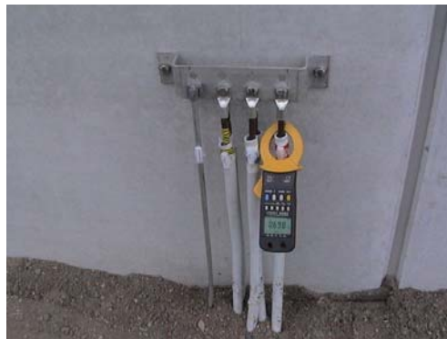
Abbildung: prüffähiger Anschluss zusätzlicher Erdungsseile
