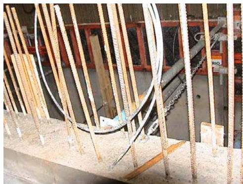
Abbildung: eingebaute Ableitungen in der Armierung
