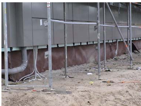
Abbildung: Ausführung zusätzlicher Erdungsseile
